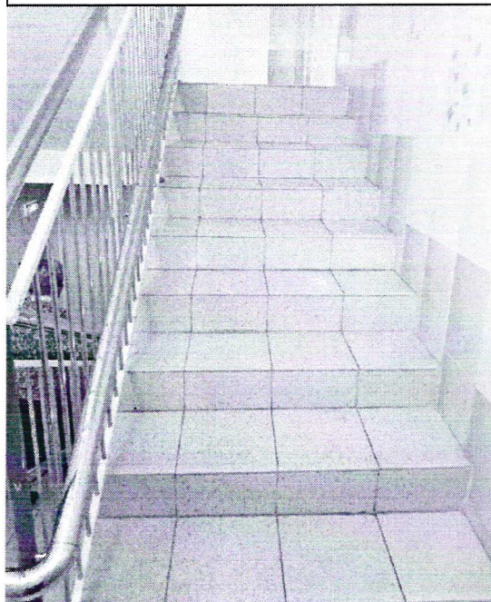
Фото 33 – Лестница внутри здания
