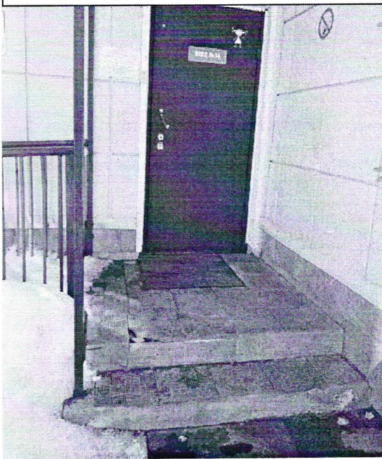
Фото 8 – Вход №14 в здание ( I этаж)
