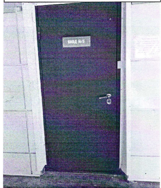
Фото 31- Дверь №5 ( II этаж)
