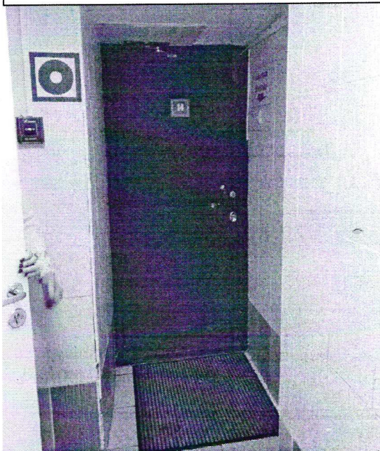
Фото 10 – Дверь №14 ( I этаж)
