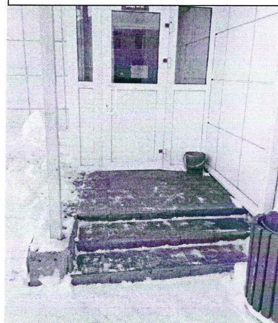
Фото 27 – Вход №12 в здание ( I этаж)
