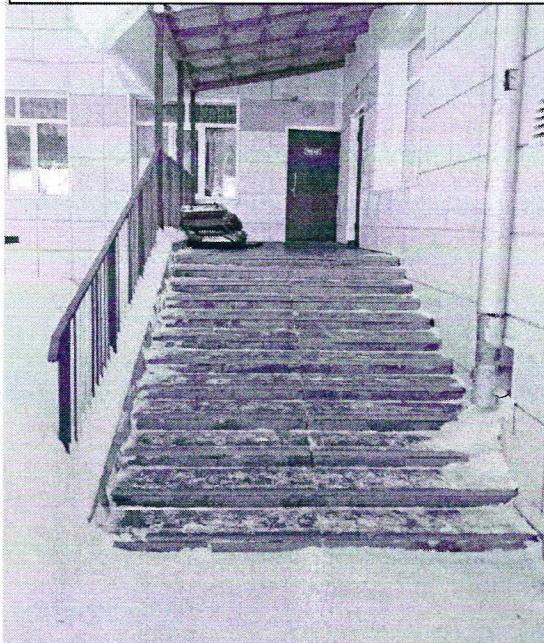
Фото 28- Вход №5,6 в здание ( II этаж)
