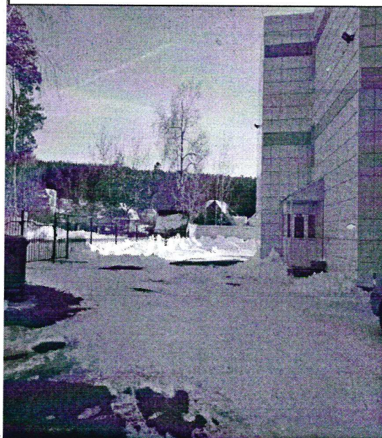
Фото 26 – Вход №12 в здание ( I этаж)
